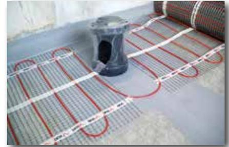
ein Kreuzen mit der Heizleitung ist nicht zulässig. Vor Verlegung des Oberbelages ist der Isolationswiderstand und der Widerstandswert der Heizmatte zu messen, die Ergebnisse sind in das Prüfprotokoll einzutragen. Eine eventuelle Beschädigung der Heizmatte kann durch die Messung früh erkannt werden, so dass noch ein leichter Austausch bzw. eine Reparatur der Heizmatte möglich ist. Die fertig ausgelegte Heizmatte ist während der nachfolgenden Belagsarbeiten mit äußerster Vorsicht zu behandeln.
