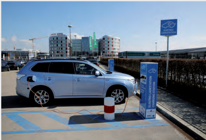
Flughafen Stuttgart mit Ladesäulen ECOLECTRA
