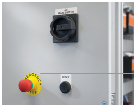
SM/CC: Auffällige und fest haftende Gerätekennzeichnungen – bestimmungsgemäßen Gebrauch von Geräten sichern
