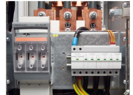
**> Bild 7: SPD-Anschluss in „V-Verdrahtung“**
